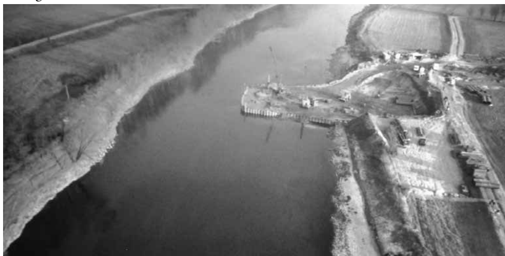
Aprile 1998. Costruzione del secondo ponte di Lodi. Foto Mario Vanini.
