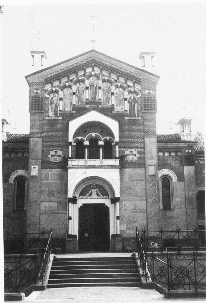
Facciata della Chiesa.
