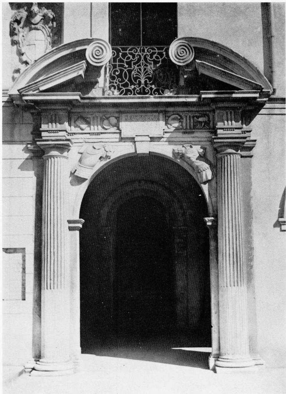
1) Crema: il primo (1634) e il secondo portale di accesso allo scalone del Palazzo ex Pretorio.
