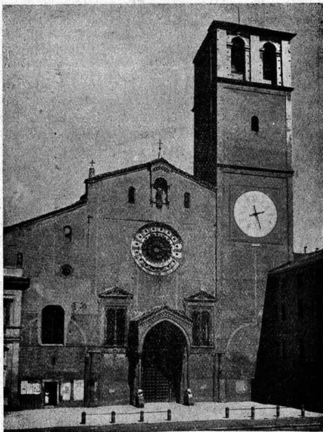
Esterno della Cattedrale di Lodi (Stato attuale).
